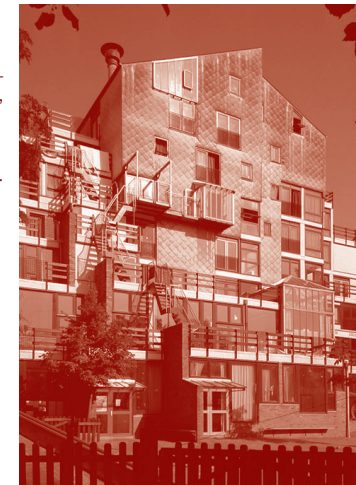
Abbildung 12: Centre social Université catholique de Louvain, Woluwe- Saint-Lambert, Architekt Lucien Kroll, 1970–72 Foto: Tijl Vereenooghe.
