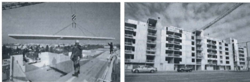
Abbildung 4: Montage der Wand- und Deckenelemente in Massivholzbauweise.
