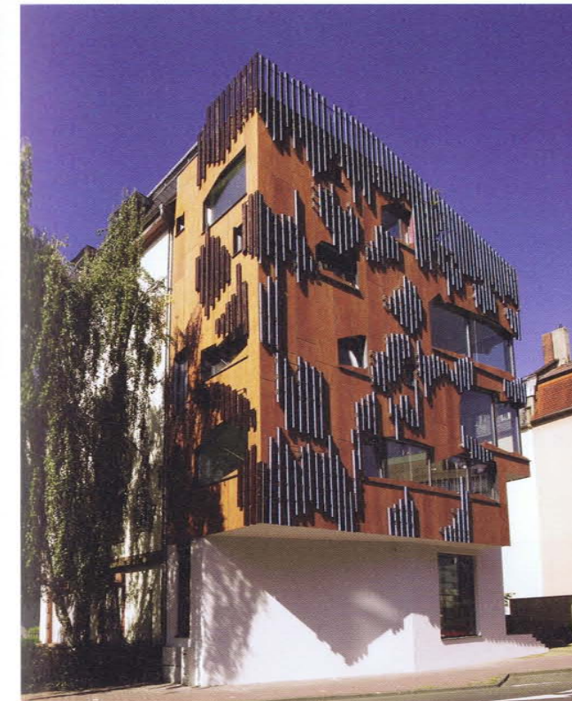
Bild 5: Blick auf die Gebäudeecke
