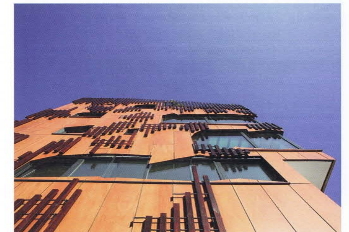
Bild 6 und 7: Detailaufnahmen der Fassade
